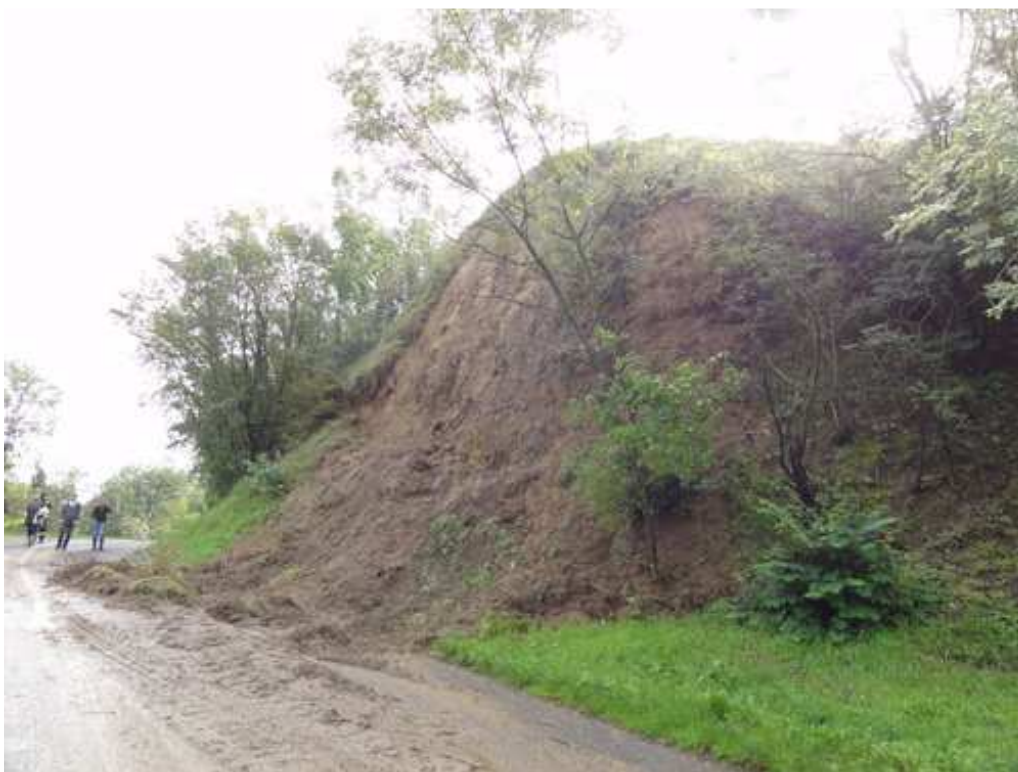
Obr. č.2: Sesuv nad silnicí III. třídy mezi D. Věstonicemi a Pavlovem, SO 202 (fotoarchiv JMK). Dle viditelných textur se jedná o povrchový splach vodou proudící přes korunu svahu. I přes mimořádnou situaci a destabilizující vlivy svah zůstal stabilní
